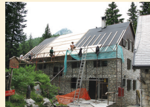
Obnova Krnska jezera 2010
