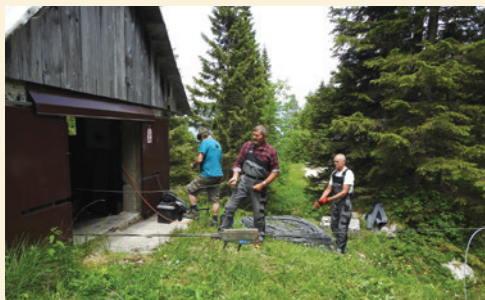
Obnova žičnice Krnska jezera 2019 Foto: Cvetko Dominko
