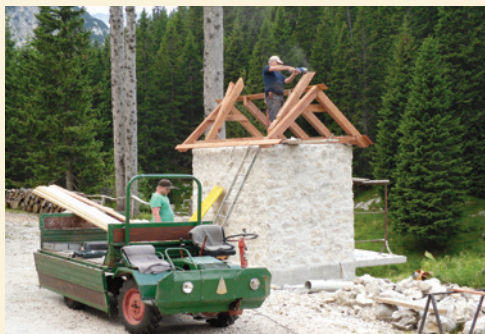
Izgradnja zunanjih sanitarij 2015
