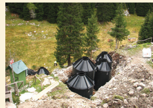
Izgradnja čistilne naprave Krnska jezera 2013
